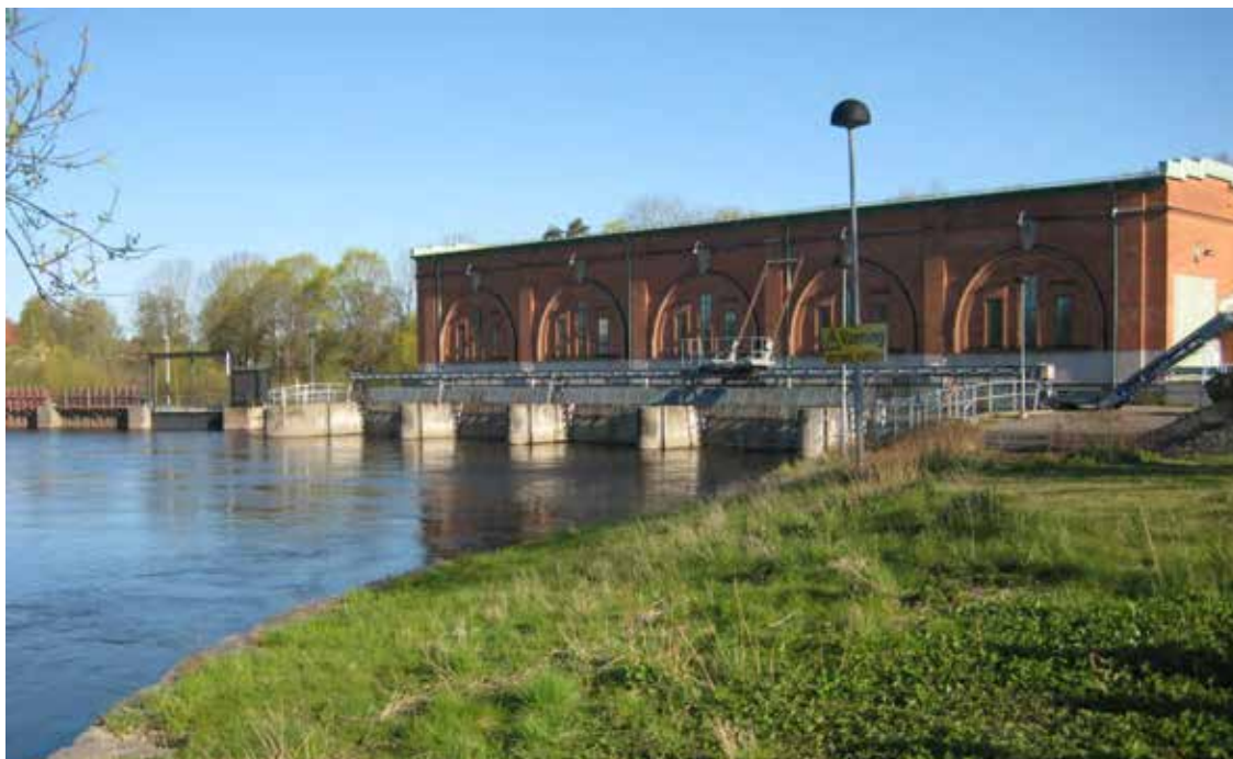
Nedströmsvy mot turbinintagen vid Fiskeby kraftverk 2014-04-23.
