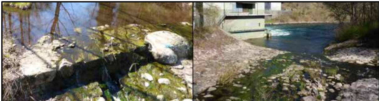
Figur 3. Spillfårans nedre del vid Malfors kraftverk.
