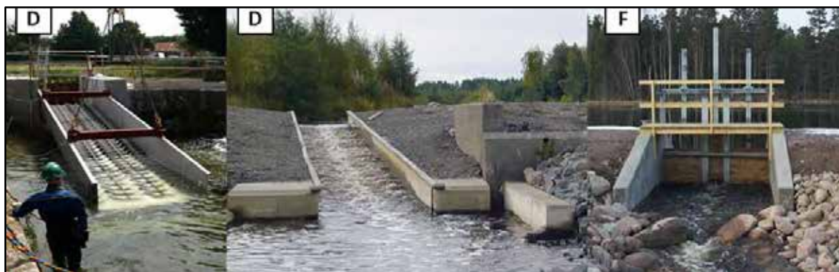
Figur 5. Exempel på tänkbara ingångar (bilderna till vänster) och utgång med flödesreglering (till höger) för inlöp.
