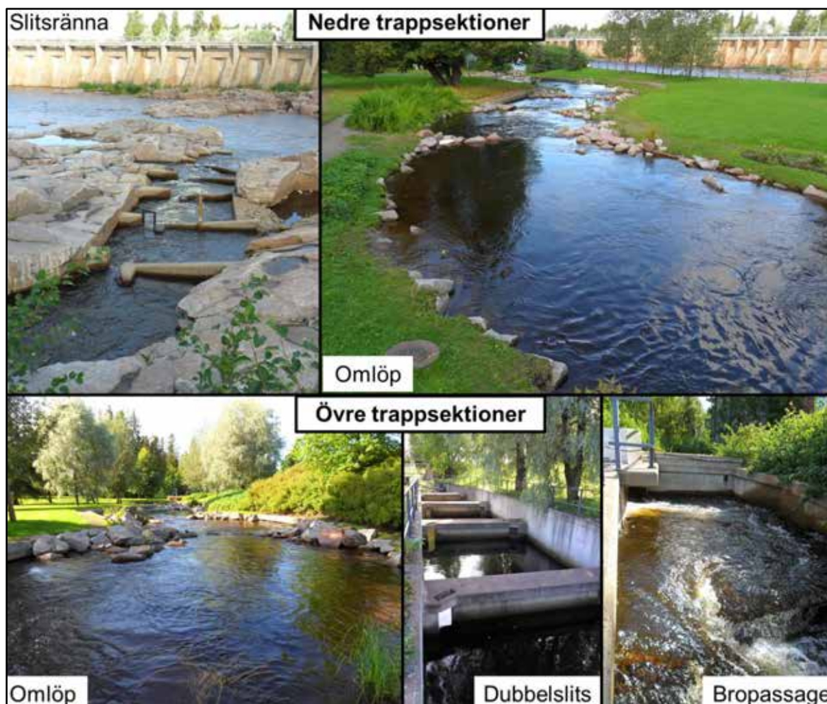
Figur 3. Exempel på ett omlöp med teknisk in- och utgång vid Oulujoki i Finland.
