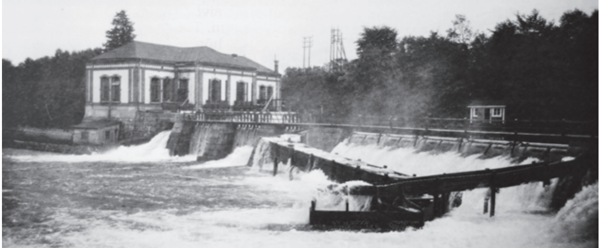
Bild 18. Nykvarns kraftstation fotograferat från norra stranden. Byggnaden till vänster är kraftverket där turbinerna är placerade och konstruktionerna i förgrunden är spilldammen. På fotografiet syns även fiskvägen som tidigare fanns vid kraftstationen. Från Carstensson m fl (1992).
