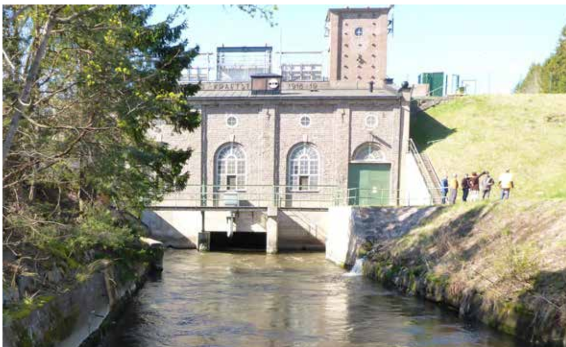
Uppströmsvy mot kraftverksbyggnaden i Svartåfors kraftverk 2014-04-22.
