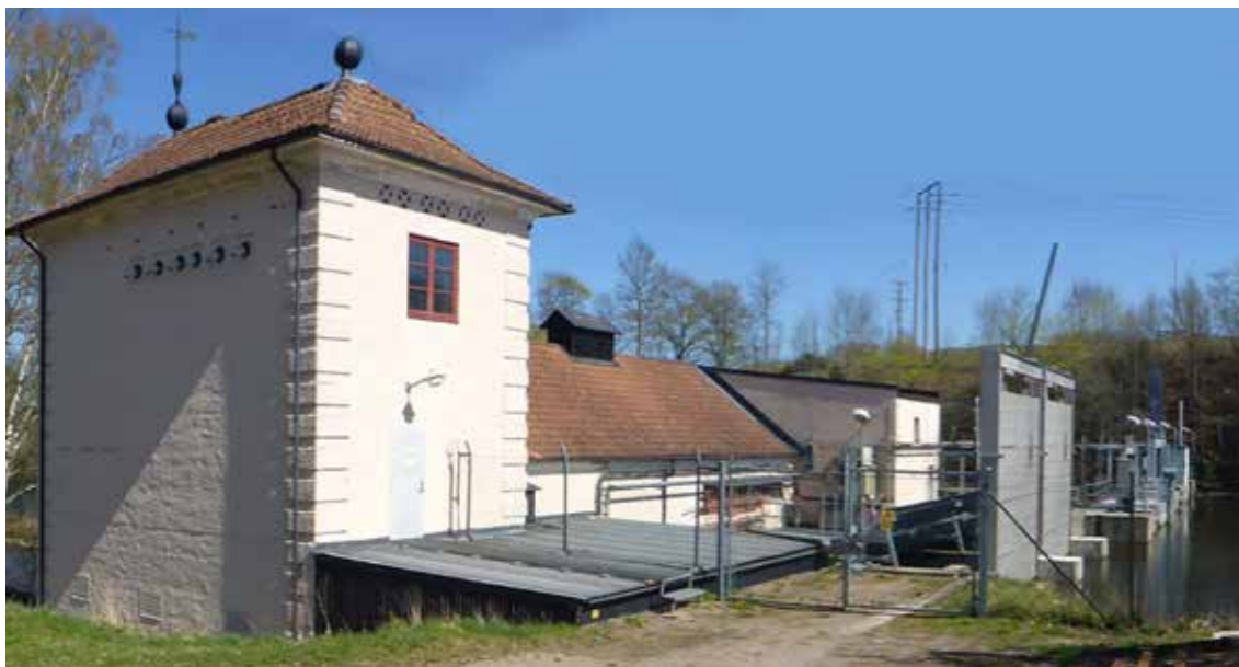
Nedströmsvy mot kraftverksbyggnad och damm i Vågforsen 2014-04-23.
