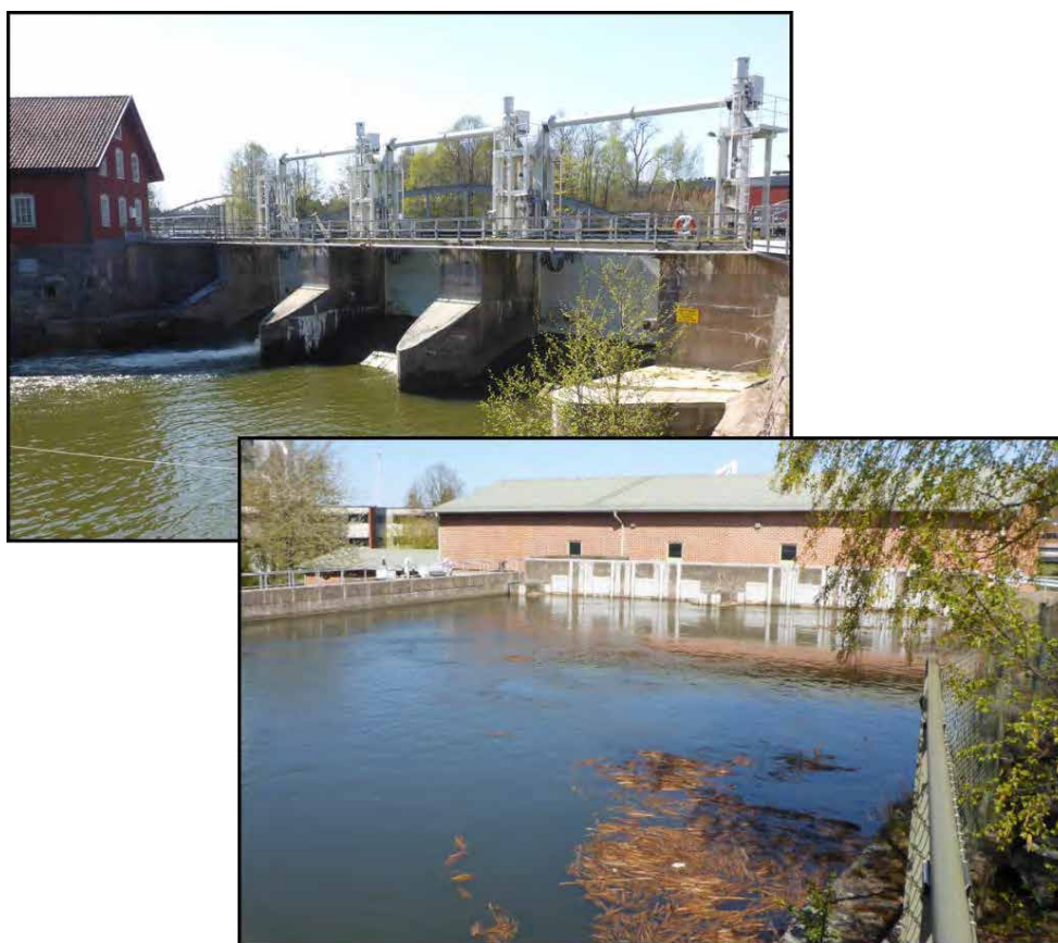
Bilder över spilldamm (övre) och kraftverksintag (nedre) vid Skärblacksa 2014-04-23.
