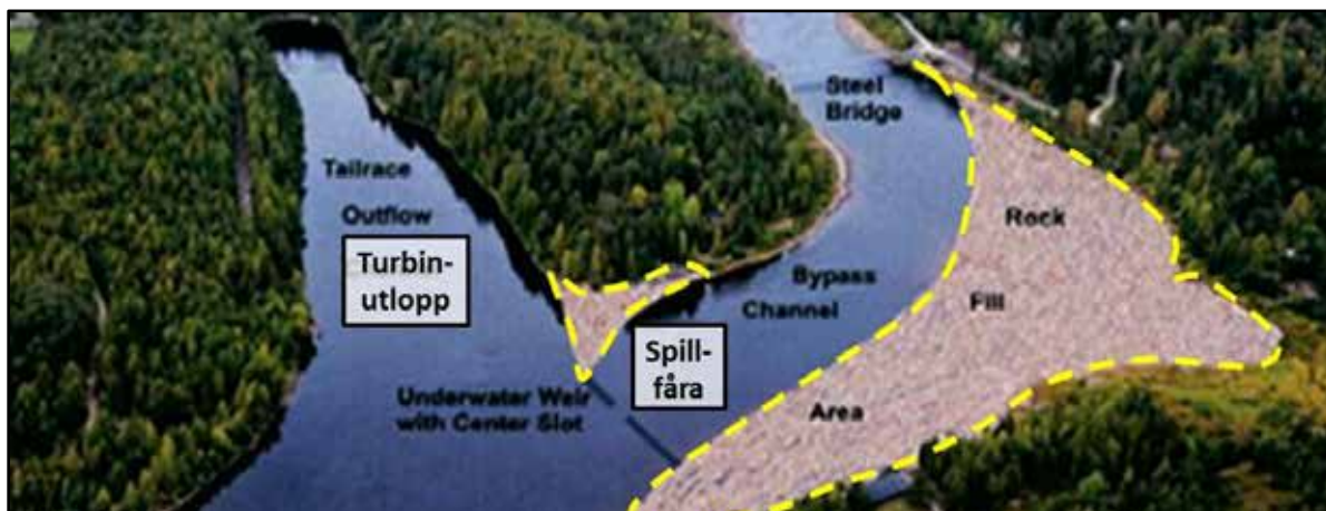
Figur 3. Exempel på ett alternativ liknande åtgärd A med utfyllnad (gulmarkerad zon) av nedre spillfåran i Umeälven för att koncentrera vattenföringen för anlockning av uppströmsvandrande fisk mot befintlig damm.
