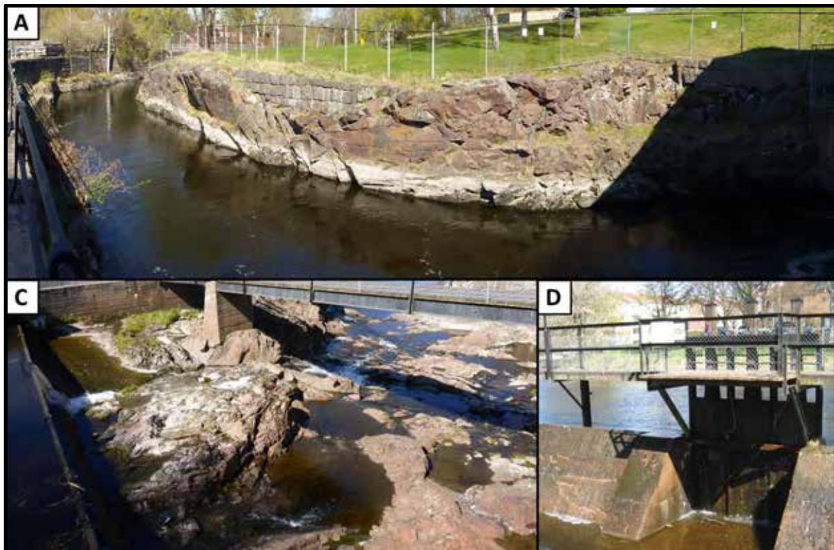
Figur 3. Områden för olika åtgärder vid Mjölby med turbinutlopp (A), nedre (C) och övre (D) spillväg.
