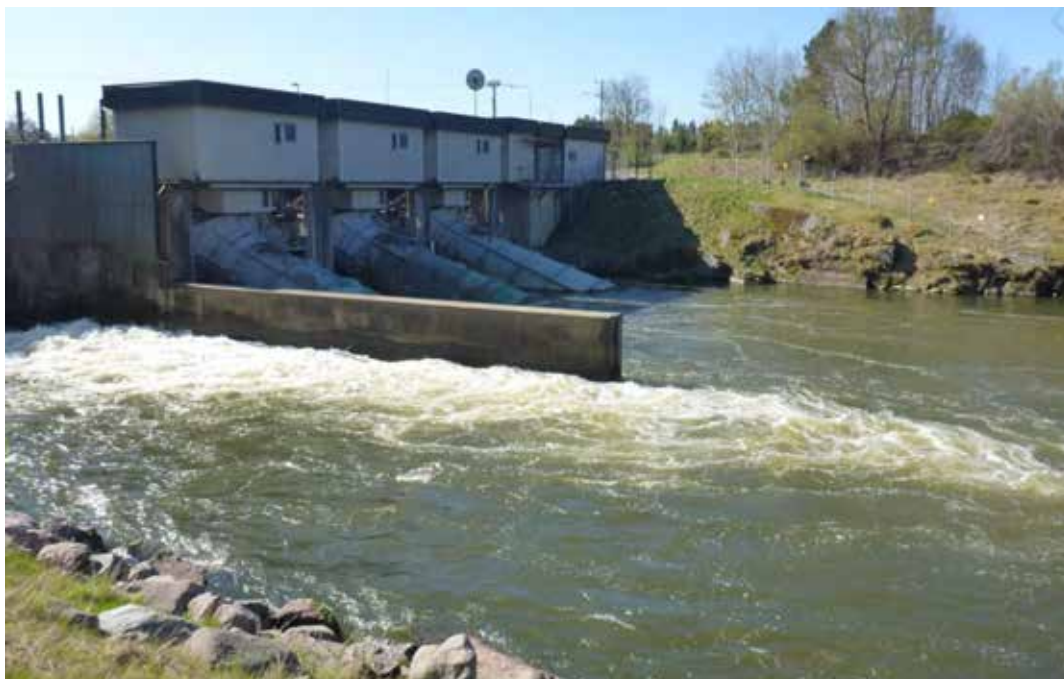
Uppströmsvy mot kraftverksbyggnad i Älvås 2014-04-23.
