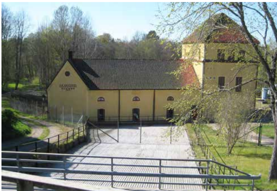
Nedströmsvy mot kraftverksbyggnad i Örebro 2014-04-23.
