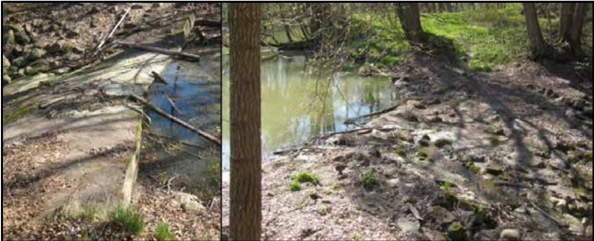
Figur 5. Betonggjutningar i den gamla fåran vid Jakobslund.
