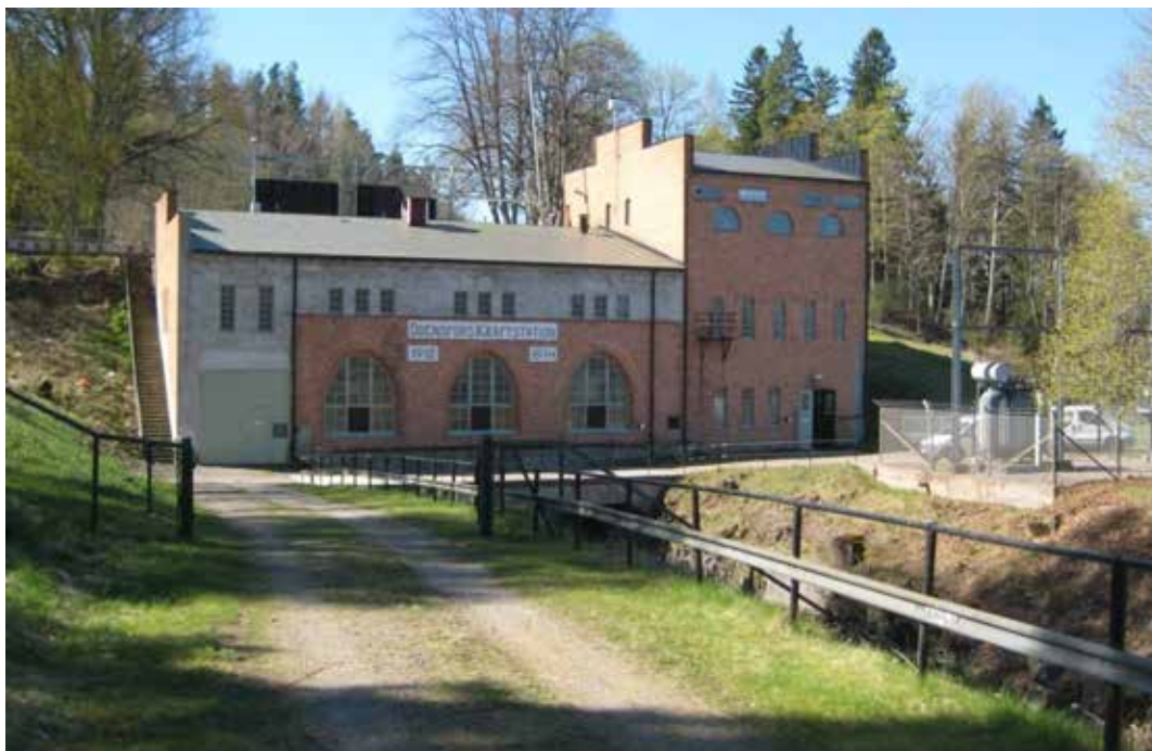
Uppströmsvy mot kraftverksbyggnaden i Odenfors 2014-04-22.
