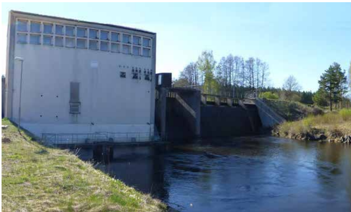
Uppströmsvy mot kraftverksbyggnad och damm i Knutsbro 2014-04-23.
