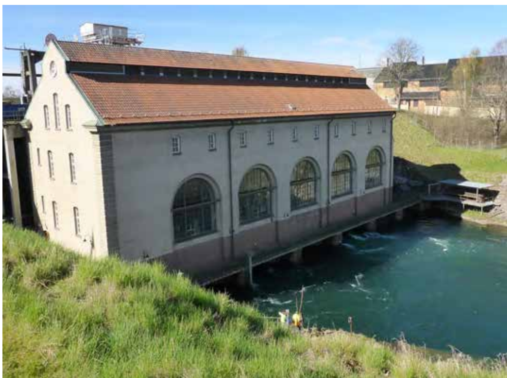
Vy nedströms kraftverket vid Motala 2014-04-24.
